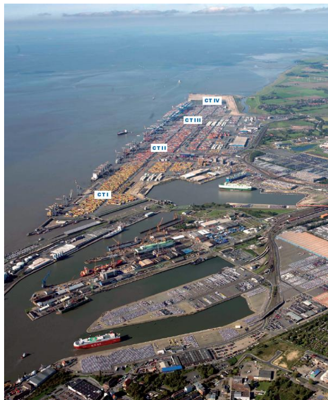
Abb. 18: Luftbild vom Überseehafen in Bremerhaven
