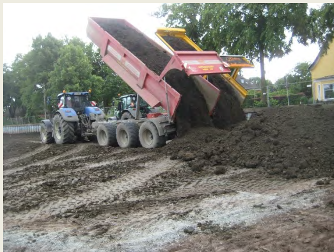
Abbildung 39: Einsatz von Baggergut im Deichbau
