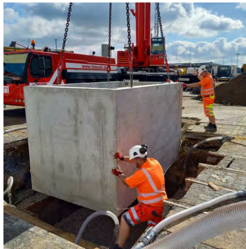
Abbildung 11: Auf dem BLG-Terminal am Nordhafen: Einbau Kabelschacht für die RoRo-Landstromanlage für die Autocarrier.
