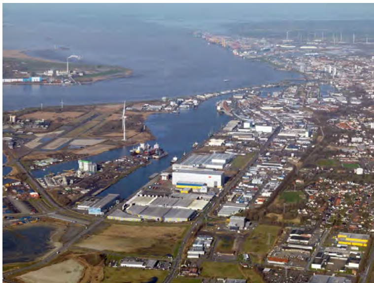
Abbildung 7: Luftaufnahme des Fischereihafens
