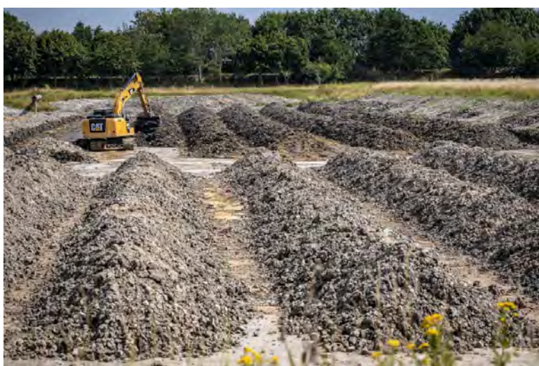
Abbildung 25: Bremen-Seehausen: Baggergut auf den Entwässerungsfeldern
