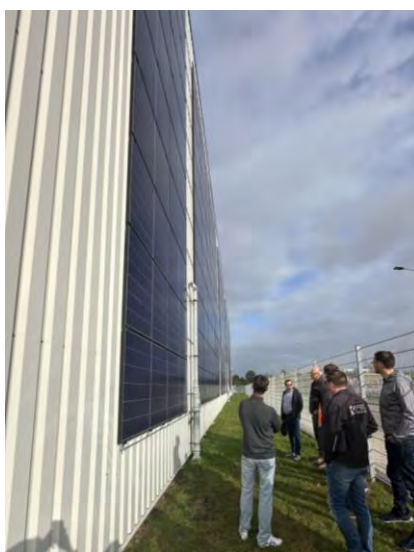
Abbildung 12: Vertreter:innen der Klimakooperation besichtigen die Fassaden-Photovoltaik-Anlage der Deutschen Steinzeug Solar Ceramics GmbH. © FBG
