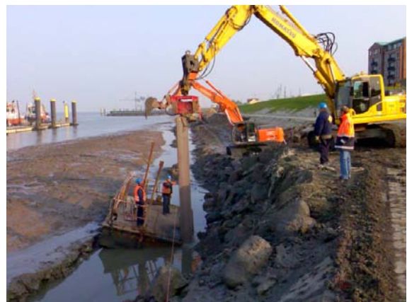
Bauarbeiten am Lohmanndeich im April 2009
