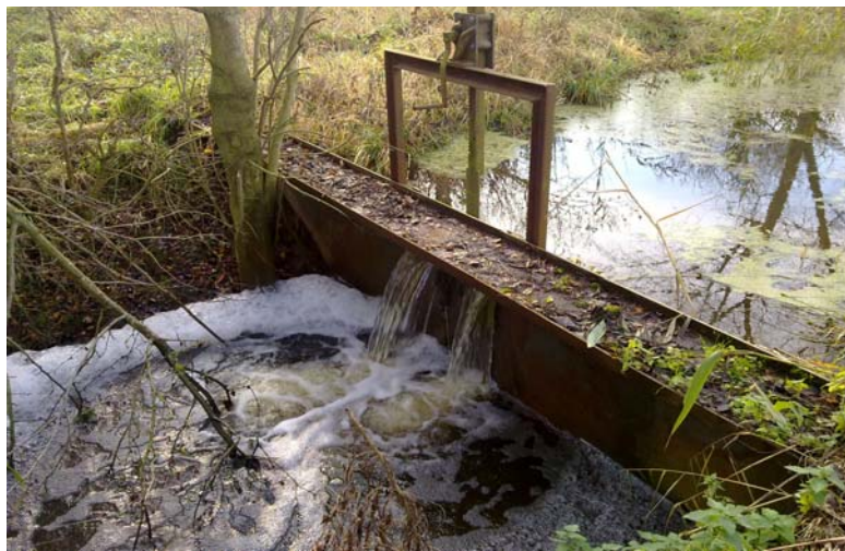
Graben mit Stauanlagen am Deichentwässerungsgraben Luneplate
