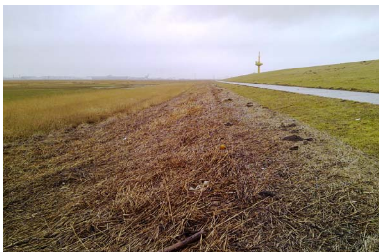
Treibsel Deichaußenböschung Luneplate
