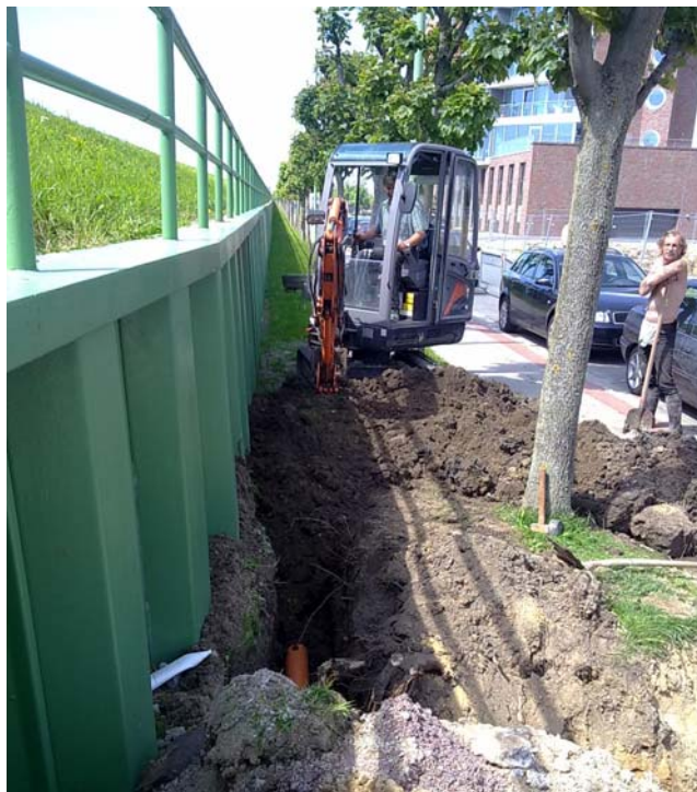
Drainage am Lohmandeich
