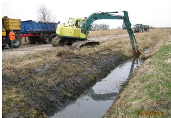
Räumarbeiten am Deichgraben
