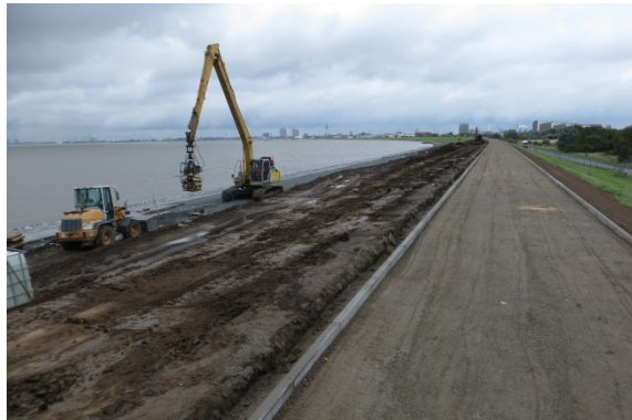
Bauarbeiten am südlichen Seedeich im September 2017
