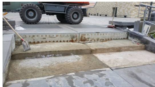
Angleichen der Stufen an der Deichtreppe beim Mediterraneo
