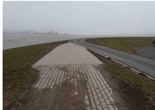
Übergang von „alter“ zu neuer Deichkrone im Süden des Seedeichs
