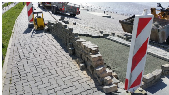
Angleichen der Pflasterung des Weserdeichs an die Betonplatten über dem Parkhaus
