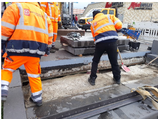
Sanierung der Treppe am Sail-City-Gebäude
