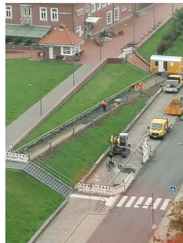
Sanierung der Deichrampe bei der Strandhalle
