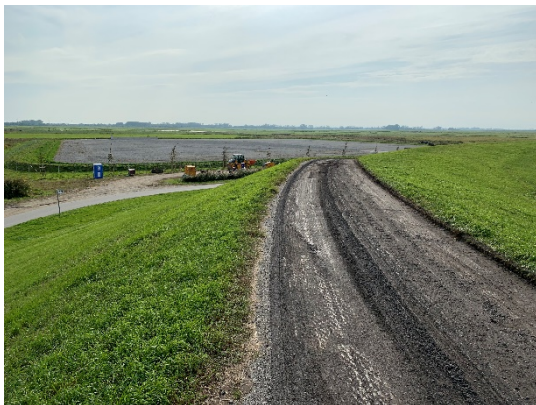
Erneuerung Deichrampe Luneplatendeich
