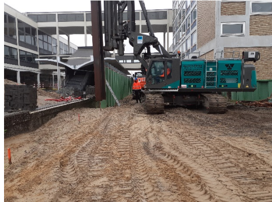
Bauarbeiten auf der Columbusinsel
