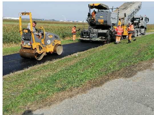
Asphaltierungsarbeiten Treibselräumweg
