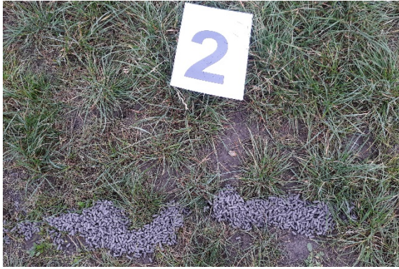
Bentonit-Pellets bei Einbau
