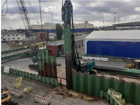
Bauarbeiten auf der Columbusinsel
