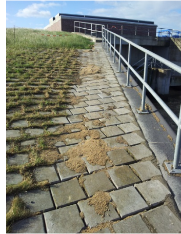
Ausbesserungsarbeiten am Sielbauwerk Norddeich
