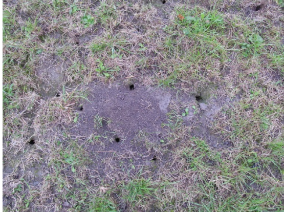
Zugänge zu Wühlmausbauten am Seedeich
