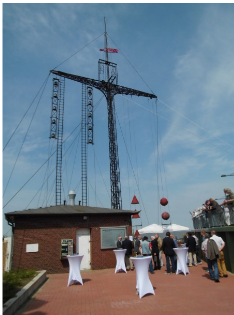
Wiederinbetriebnahme des Wasserstandsanzeigers am 27.06.2014
