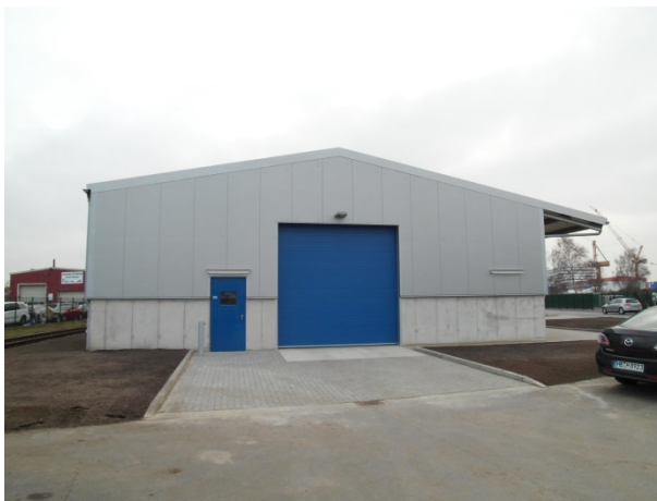
Hochwasserschutzhalle an der Brückenstraße
