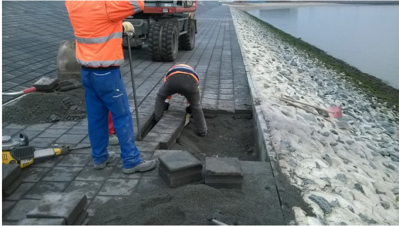
Ausbesserungsarbeiten am Weserdeich
