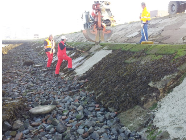
Ausbesserungsarbeiten am Seedeich
