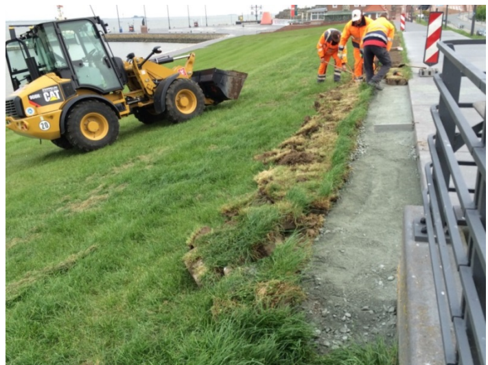
Ausbesserungsarbeiten an der Deichkrone des Weserdeiches
