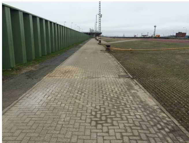
Neue Spundwand neben der Schleusenkammer der Nordschleuse
