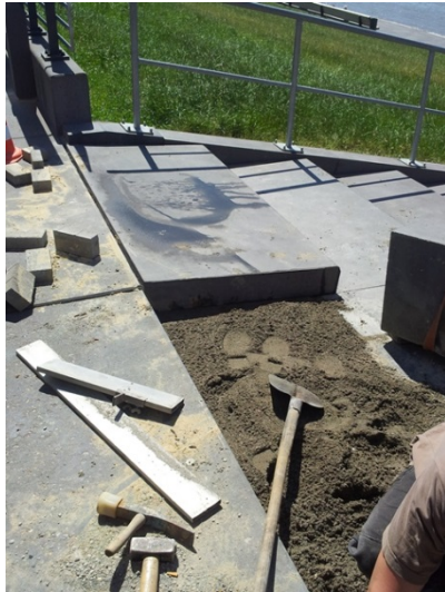
Ausbesserungsarbeiten an einer Treppe des Weserdeiches
