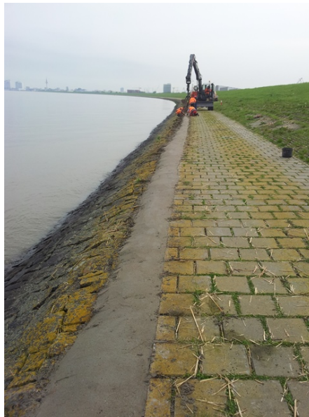
Ausbesserungsarbeiten am Seedeich
