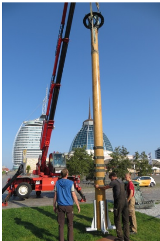
Wiedererrichtung des Sturmflutpfahls
