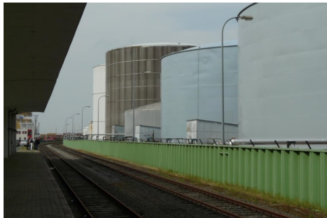
Vorhandene Hochwasserschutzwand auf der Columbusinsel
