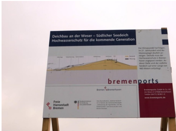
Bauschild an der Baustelle des Seedeichs
