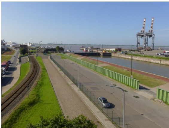
Neue Spundwand an der Nordschleuse
