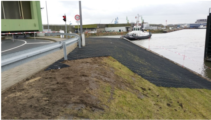
Einbau von Rasengitter an der Fischereihafenschleuse
