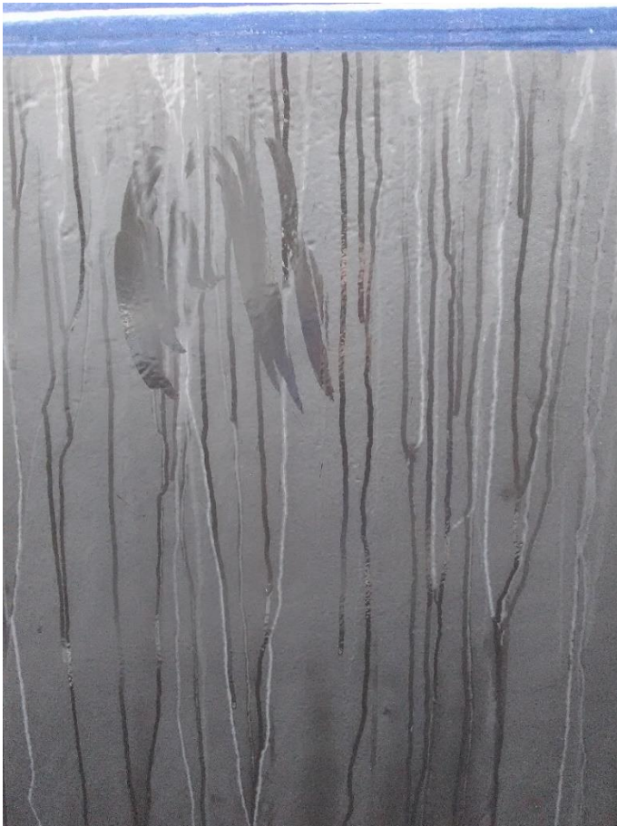
Abb. 6: Unterwasser Beschichtung der „Polarstern“ am 05.10.2023, Bremerhaven
